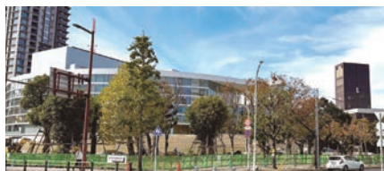
来春完成の福岡市民ホール前庭
